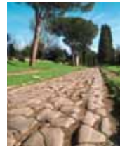
Die Via Appia nahe Rom hat teilweise noch heute den originalen Steinbelag.
