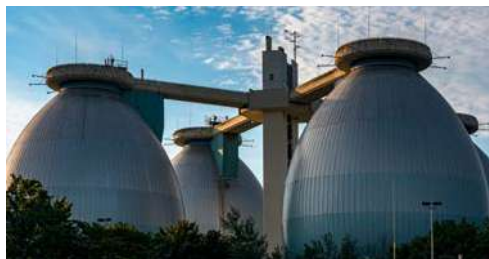
B3 Biogasgewinnung (bis zu 70 % Methan) aus dem Klärschlamm kommunaler Kläranlagen. Methanbakterien produzieren aus Biomasse Methan. Dabei muss der pH-Wert im Behälter konstant zwischen \text{pH} = 5,8 und \text{pH} = 6,5 gehalten werden.
