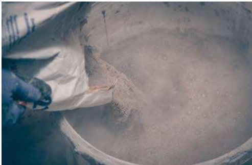
B3 Chemische Reaktion zwischen Zement und Wasser. Es wird Wärme freigesetzt.
